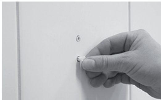
[ Bild 3.] Montera plastplugg avsedd för 5.5mm hål.
