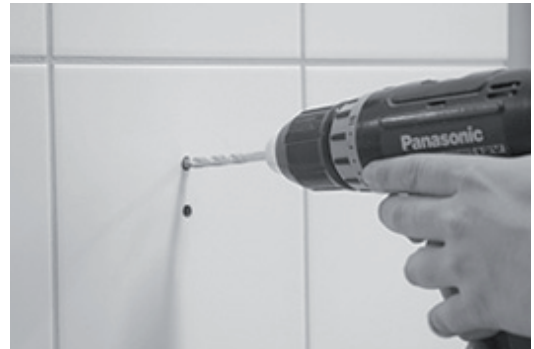
[ Bild 2.] 7 mm borrar endast genom kakel (använd kakelbollar) Våtrumssilikon i hålet.
